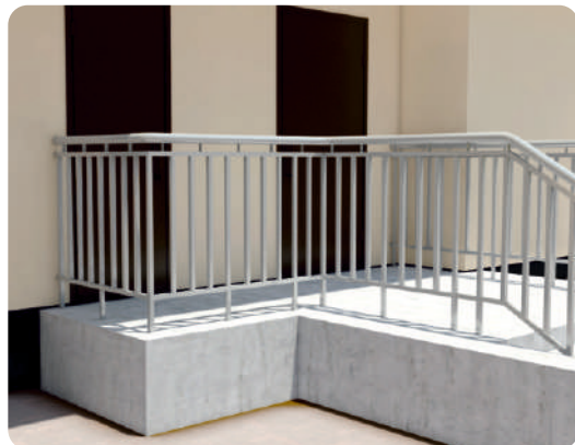
Ограждение из профильной трубы
